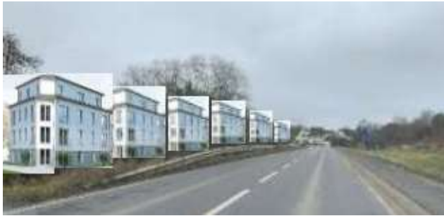
Blick von Siershahn kommend in Richtung Bahnhof Wohnungen /Büros an L303 mit Blick zur Alten Wiese
